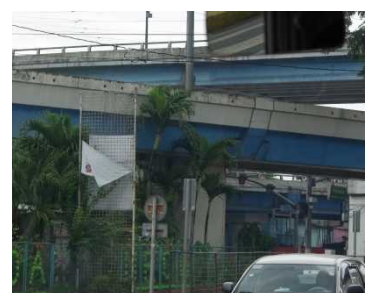
写真-12 コンクリート上部工の塗装
