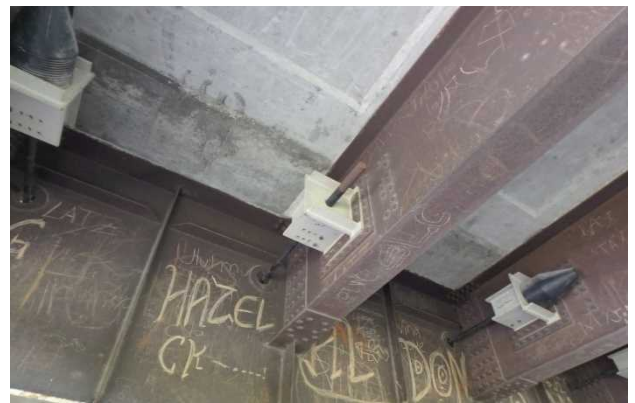
写真-15 手が届く範囲の落橋防止装置定着部の盗難
