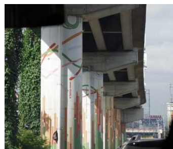
写真-11 コンクリート橋脚の塗装
