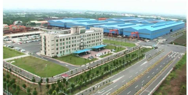
写真-1 CSSC 高雄工場全景
