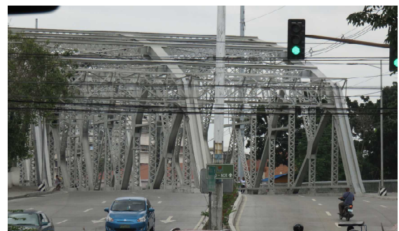
写真-13 アラヤ橋 (中央分離帯にも主構がある)
