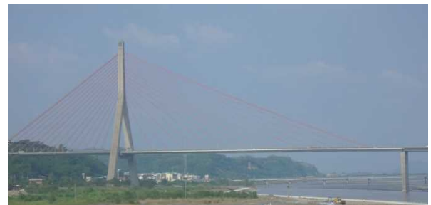
写真-2 高屏溪河川橋
