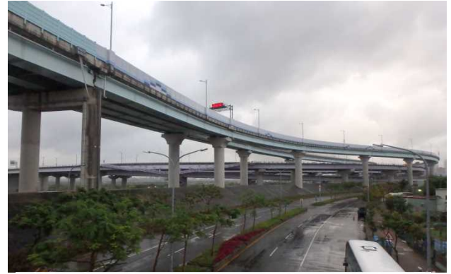
写真-4 台北の二重疏洪道付近の高架橋群
