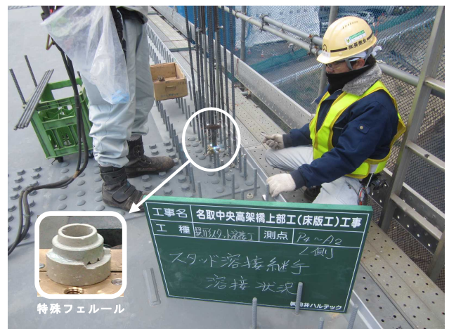
写真-4 突合せアークスタッド溶接施工状況(連結板上)
