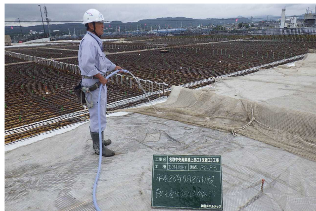
写真-2 コンクリートの湿潤養生
