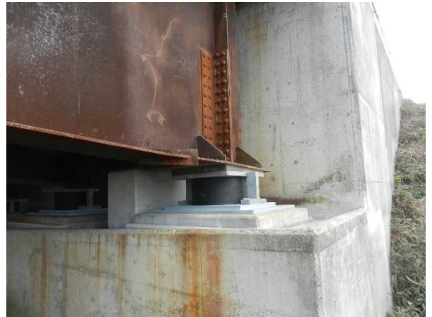
復旧完了状況
