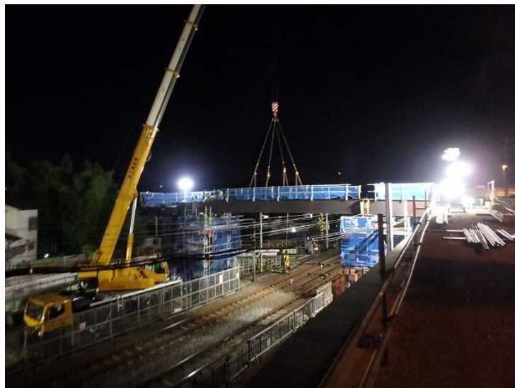
120t吊オールテレーンクレーンによる主桁架設
