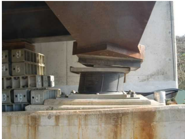
地震による損傷状況
