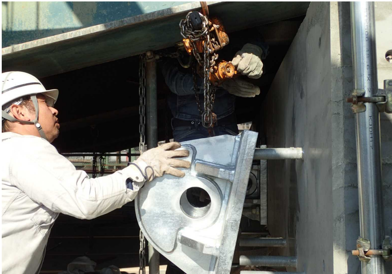
下部工付き落橋防止装置ブラケット設置状況
