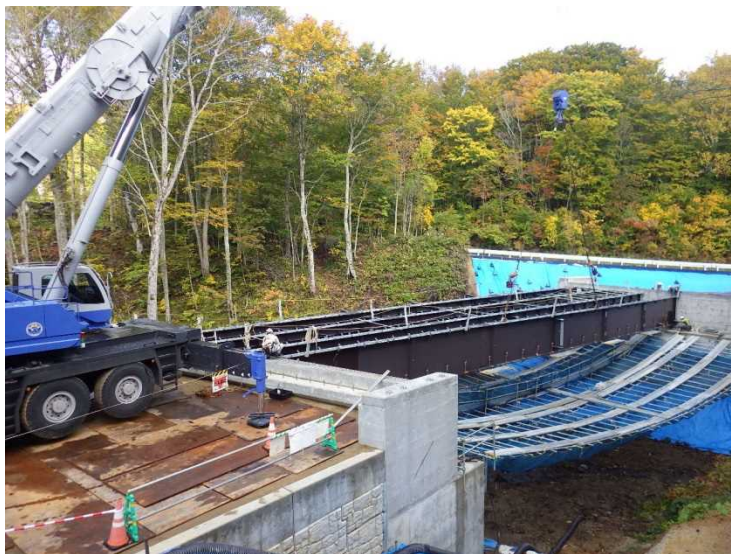
220t 吊オールテレーンクレーンによる主桁架設
