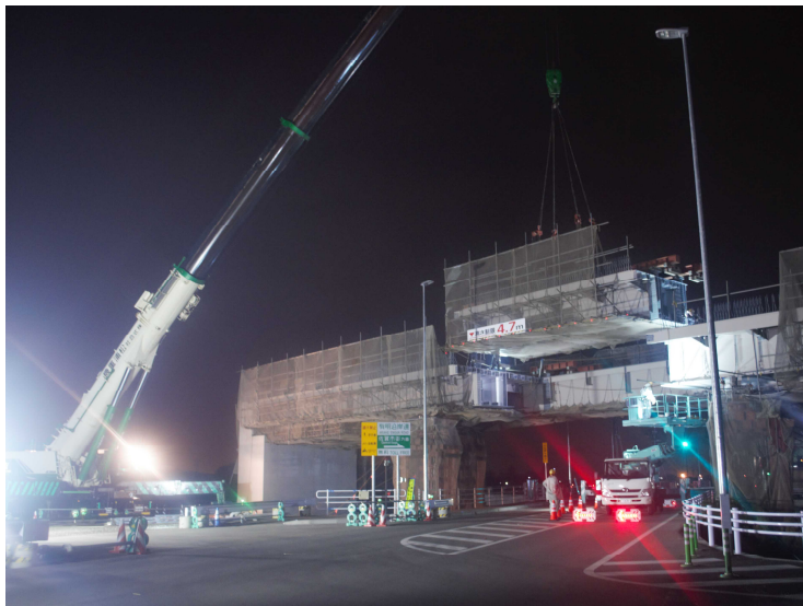
400t吊オールテレーンクレーンによる主桁架設
