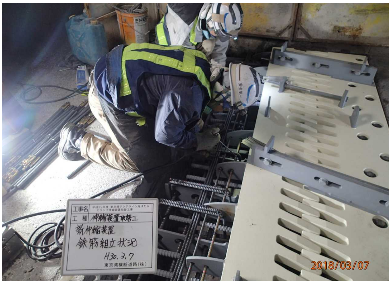
旧伸縮装置を撤去後、新伸縮装置を設置するため鉄筋組立を行っている状況
