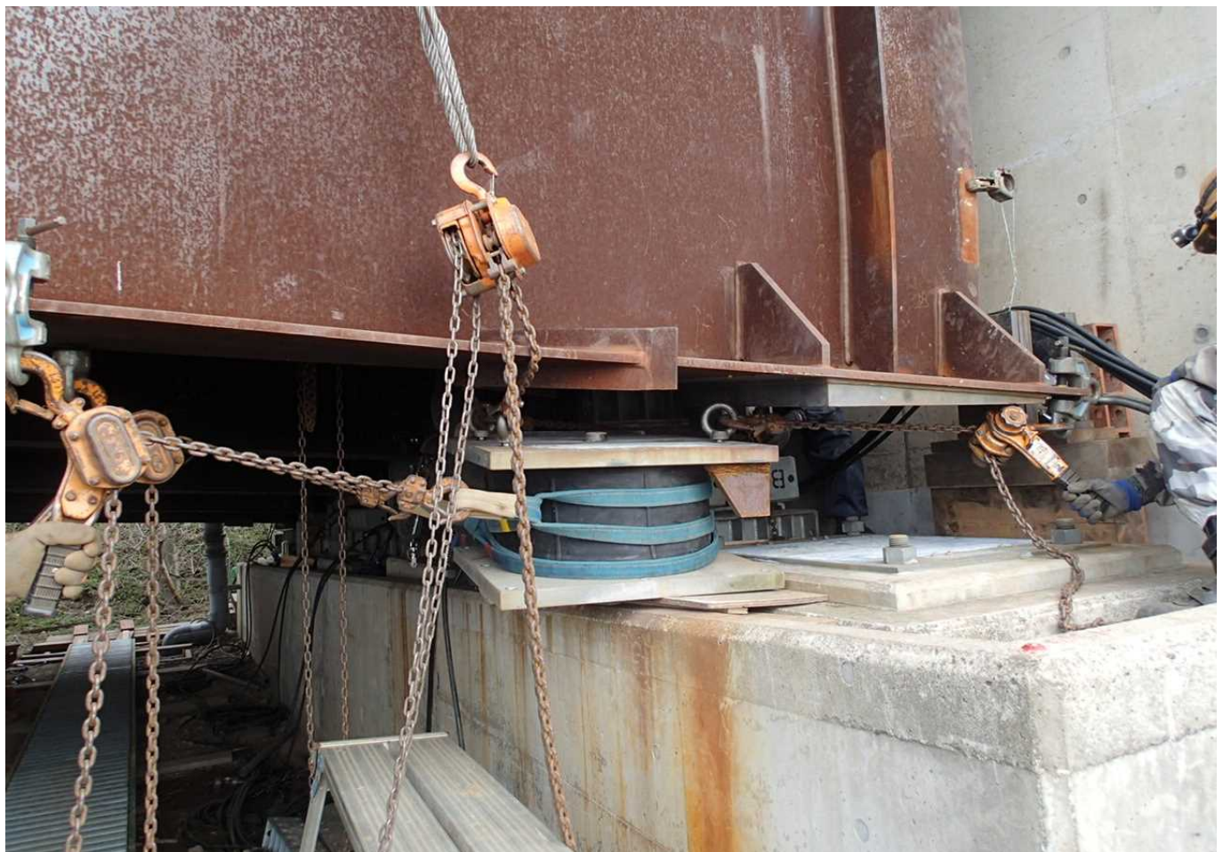
支承撤去状況
