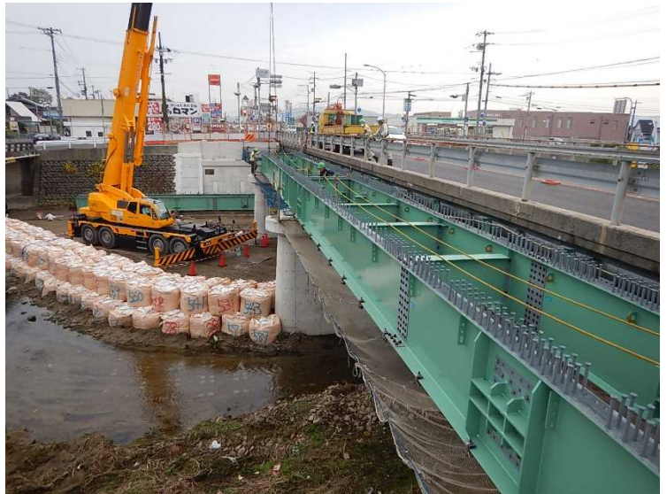
60t吊ラフテレンクレーンによる主桁架設
