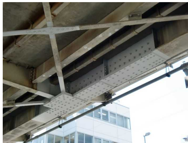
下フランジおよびウェブ取替完了
