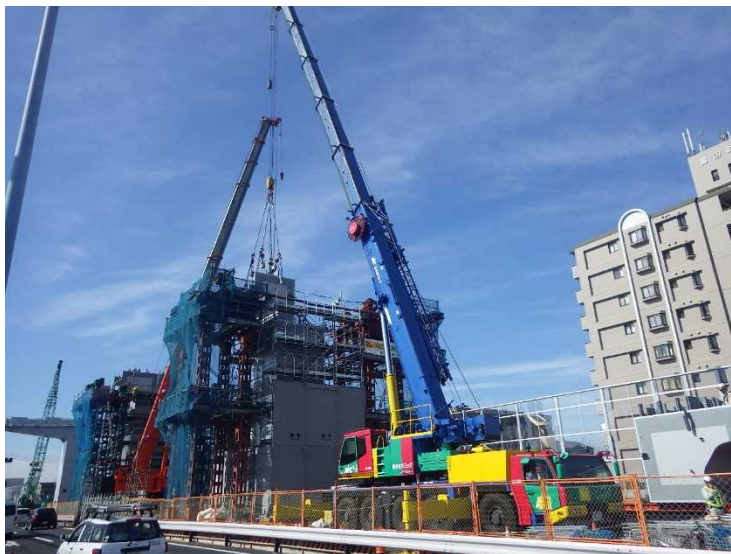
130t吊オールテレーンクレーンによる橋脚架設
