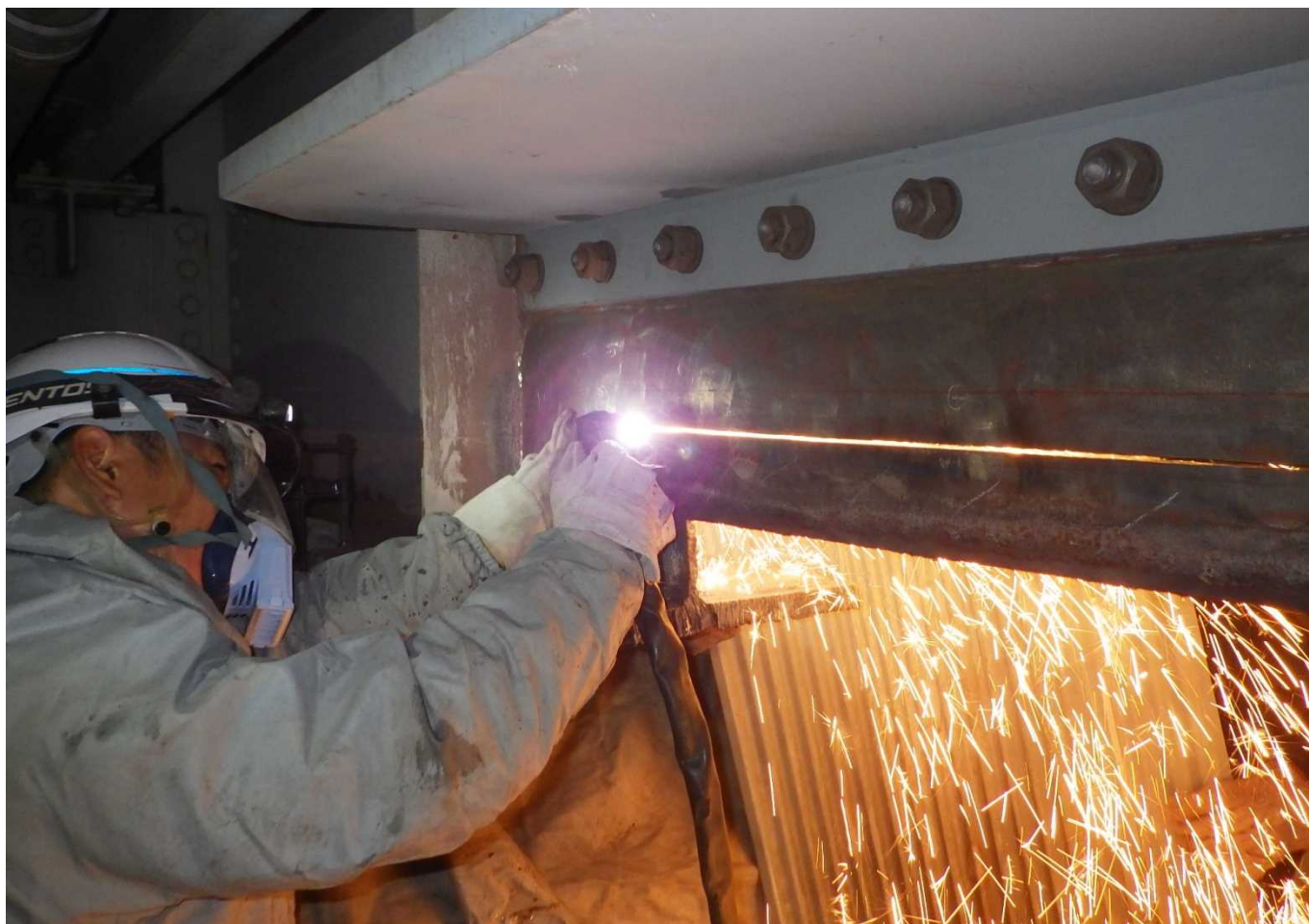
補強部材取付後、主構造の切断を行っている状況
