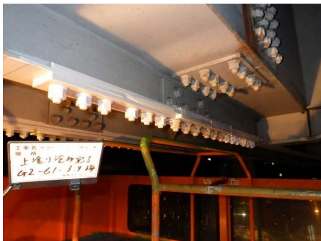
下フランジ補強板（連結板兼用）取付完了
