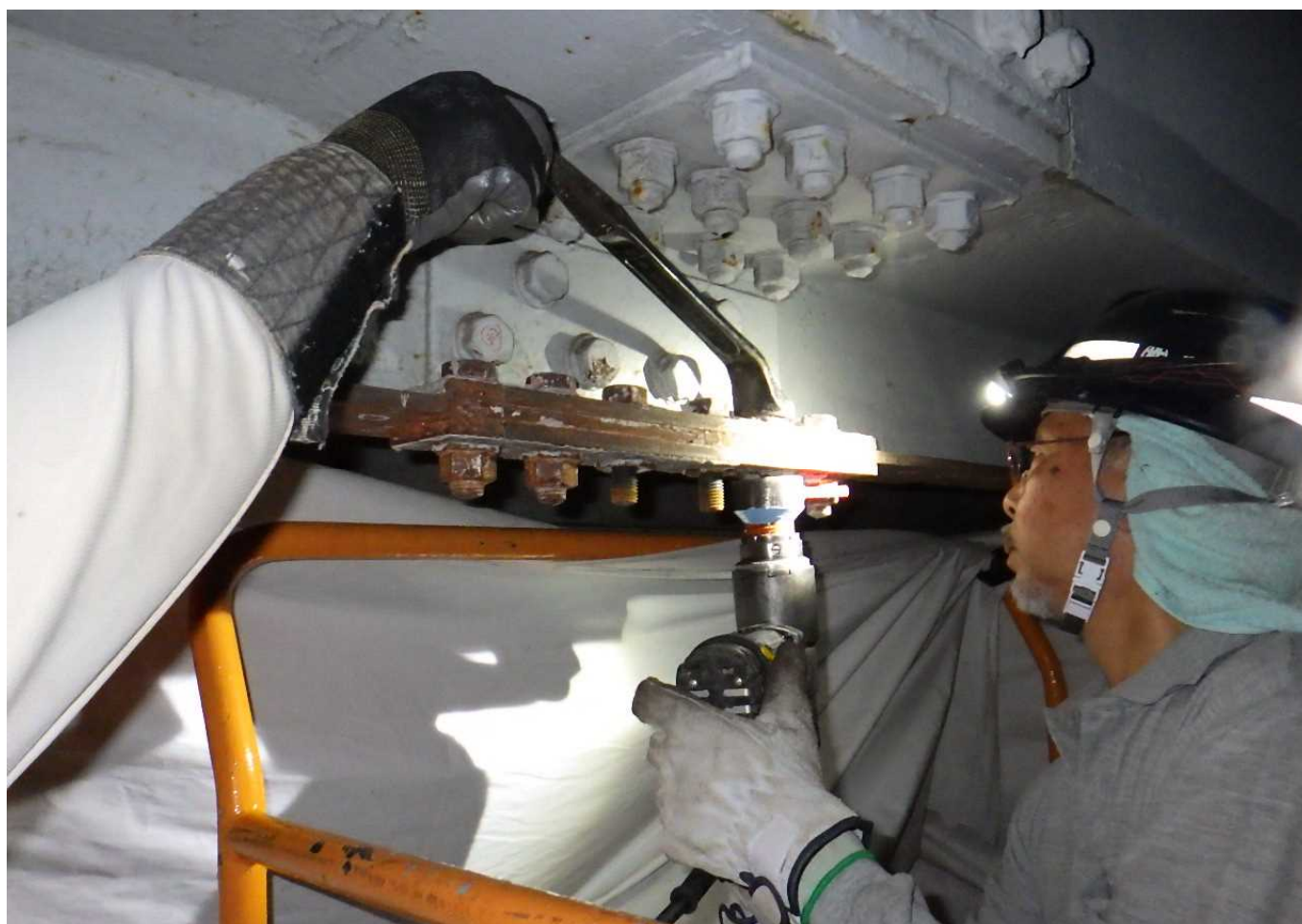
下フランジ補強板（連結板兼用）取付前の既設ボルト撤去状況
