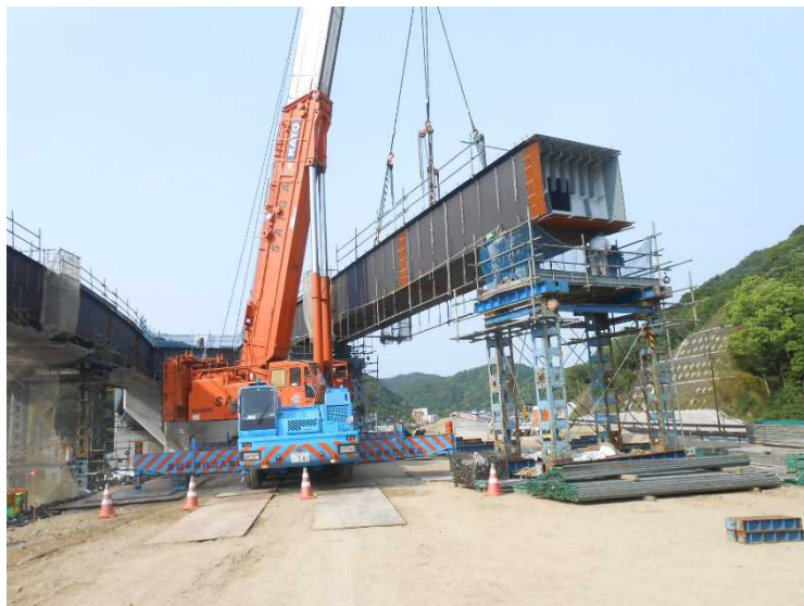
200t吊オールテレーンクレーンによる主桁架設
