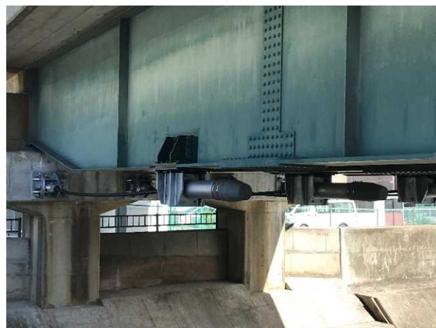
落橋防止装置取付完了
