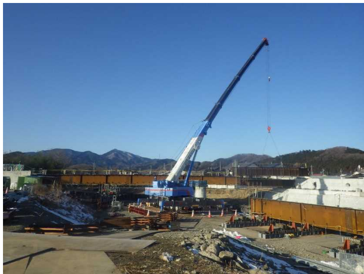
160t吊オールテレーンクレーンによる主桁架設
