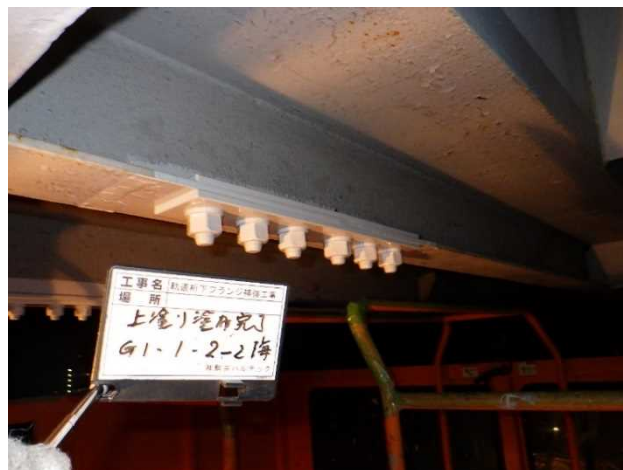
下フランジ補強板取付完了
