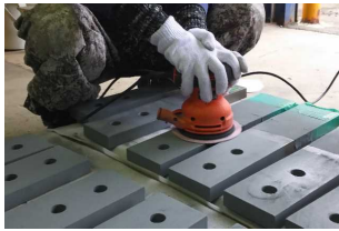
図-3 ケレン作業の状況（ダブルアクションサンダ）
