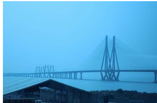
写真-8 シーリンク橋
