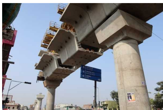
写真-3 アーメダバードメトロ高架部架設現場
