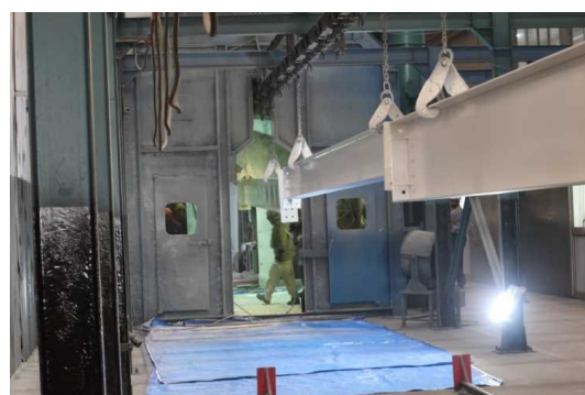
写真-5 塗装作業状況
