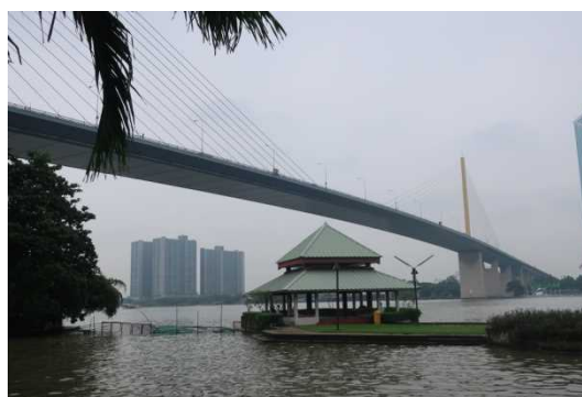
写真-9 ラマ9世橋
