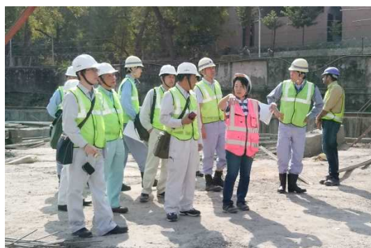
写真-2 視察団と阿部プロジェクトマネージャー （工事概要説明状況）
