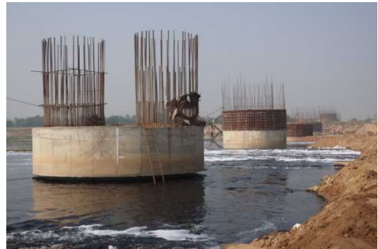
写真-6 サバルマティ橋下部工施工状況
