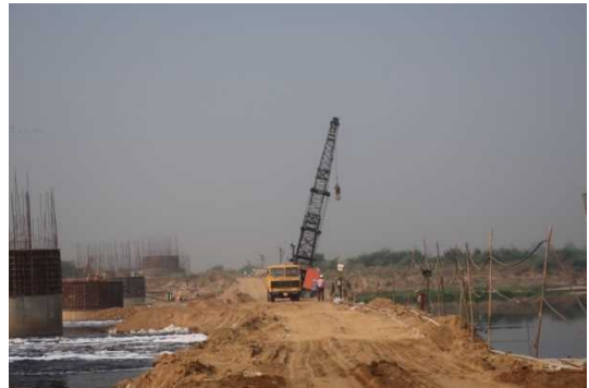
写真-7 工事用通路
