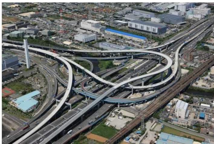
写真-1 高谷 JCT の全景
