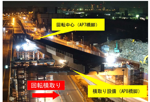
写真-4 A ランプ架設状況
