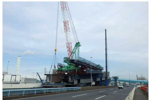
写真-3 C2ランプ架設状況
