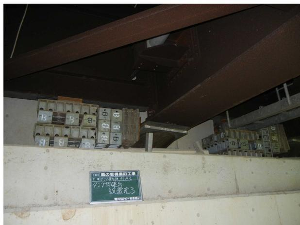
写真-24 工事車両用反力架台
