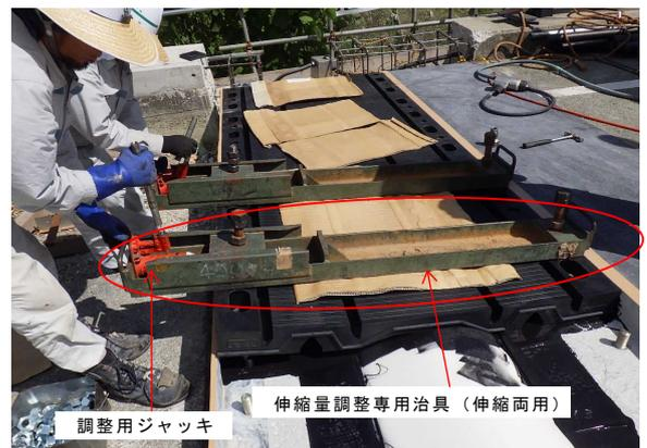
写真-21 伸縮装置設置作業
