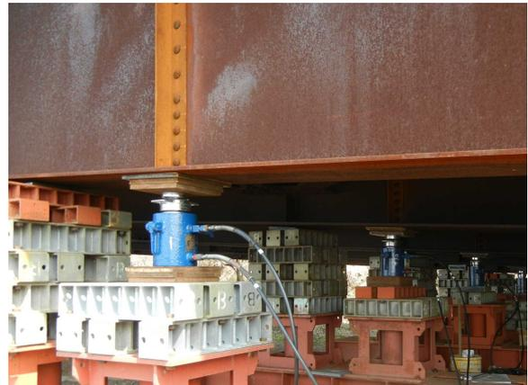
写真-11 端支点ジャッキアップ設備
