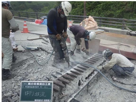
写真-19 伸縮装置はつり作業
