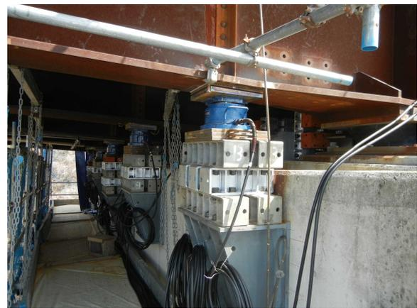
写真-12 中間支点ジャッキアップ設備
