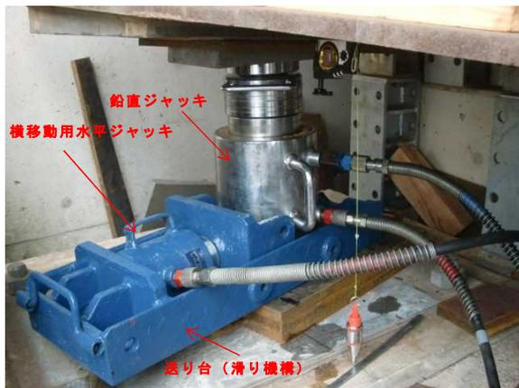
写真-13 A1橋台部桁移動設備
