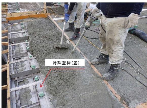
写真-20 伸縮装置コンクリート打設作業
