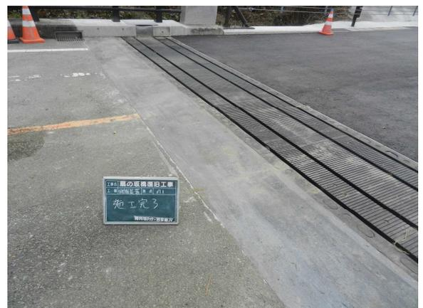
写真-22 伸縮装置設置完了
