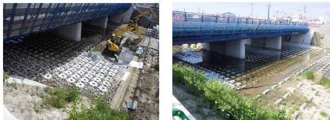
写真-7 根固め工施工状況（左）および完成（右）
