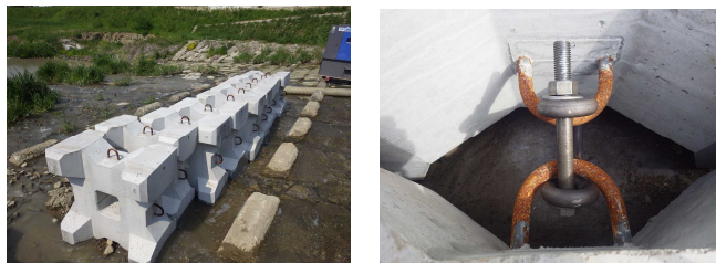
写真-8 ブロック形状（左）および連結シャックル（右）
