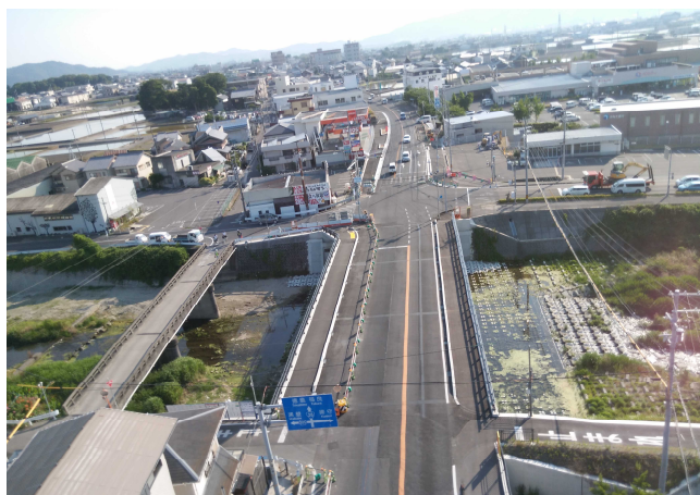
写真-9 完成写真（小型ドローン撮影）
