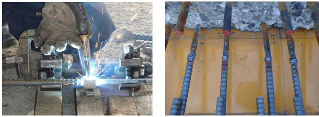
写真-2 鉄筋の溶接継手
