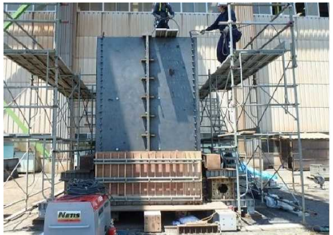
写真-3 施工試験供試体
