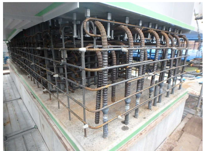
写真-7 下部工境界部の配筋状況
