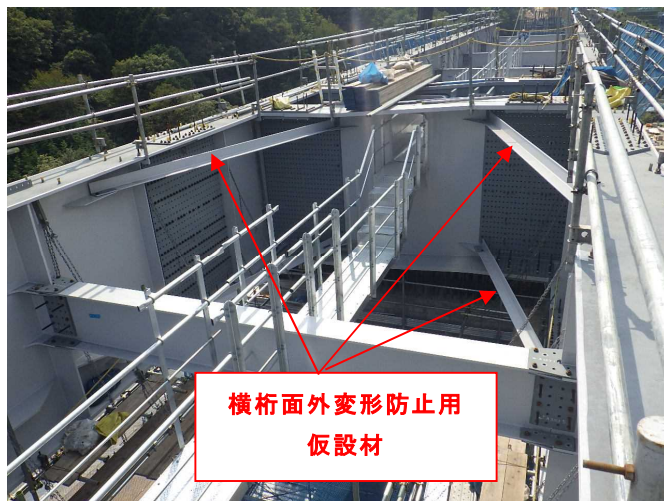
写真-5 面外変形防止用仮設材
