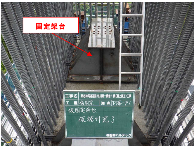
写真-4 鋼桁固定架台
