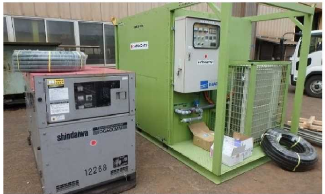
写真-2 水温管理ユニット
