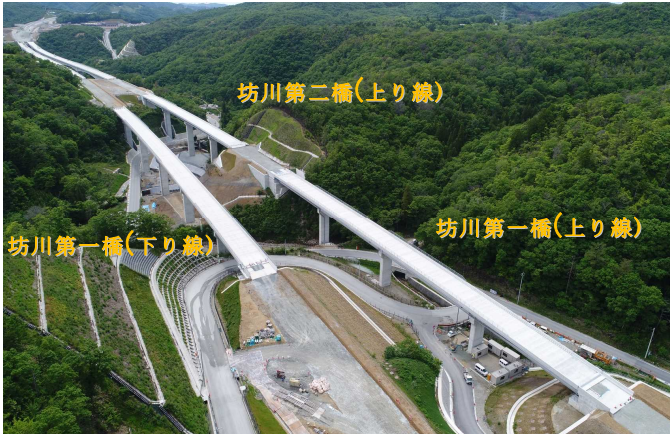
写真-1 工事全景
