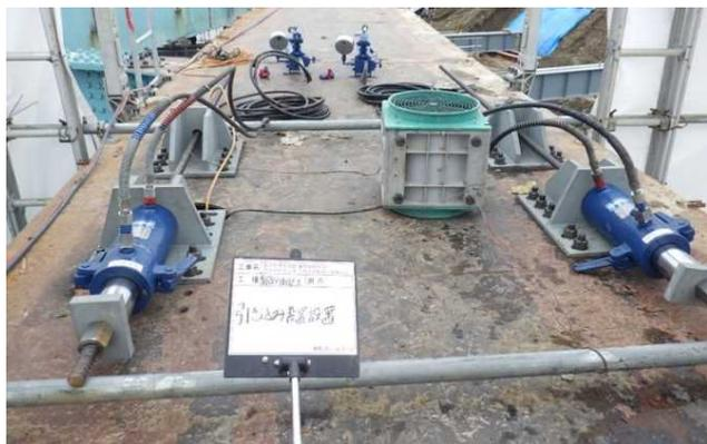
写真-5 鋼桁引込み装置
