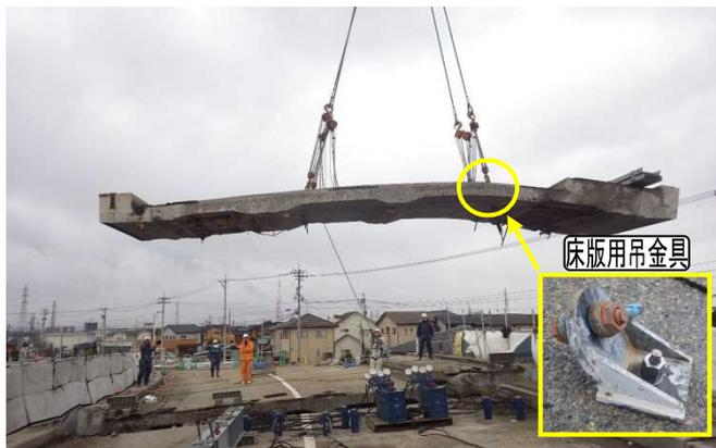
写真-2 床版吊撤去状況
