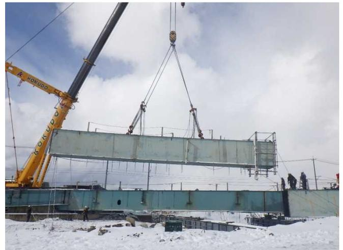
写真-3 鋼桁吊撤去状況
