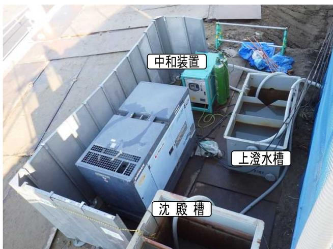
写真-4 沈殿槽と炭酸ガス中和装置
