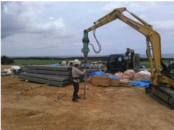
写真-1 基礎杭施工状況
