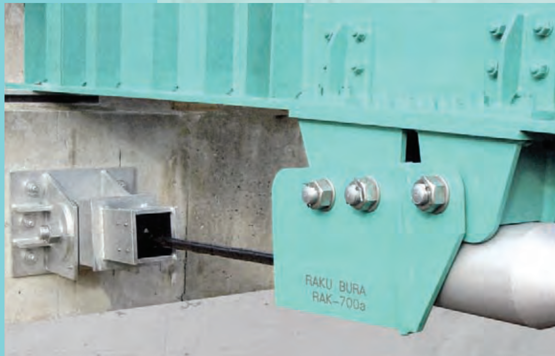
供試体による施工試験状況
