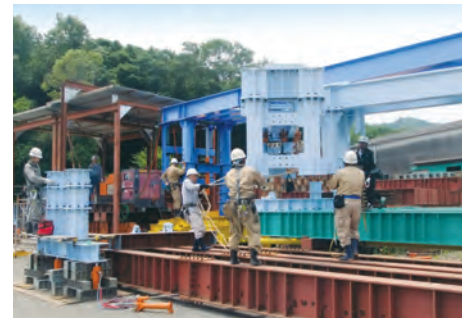
2. 現地に到着したら油圧ジャッキで装置全体を持ち上げる。格納していた横取りビームを展開し手動で既設橋梁を巻き上げる。
