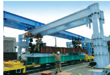
3. 巻き上げ・横移動した既設橋梁を運搬してきた新設橋梁の上方に収納する。
