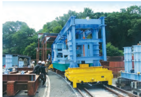
1. 車輦基地にて、新設橋梁を積み込み、現地まで横取りビームを格納して低い体勢で走行する。
