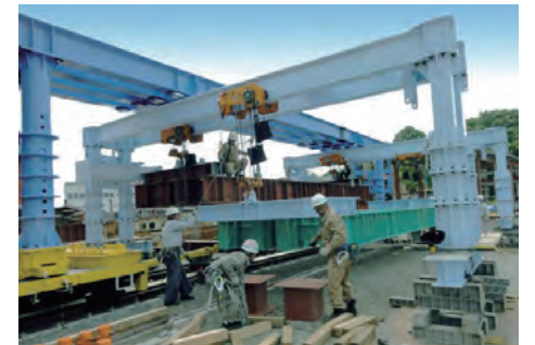
4. 引き続き新設橋梁を架設し、既設橋梁を台車に積み込む。横取りビームを格納し、油圧ジャッキで装置を低い体勢にして車輦基地まで帰還。
