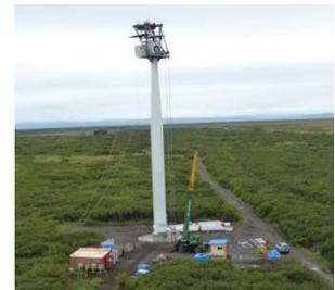
3号機ナセル吊上げ完了直後
