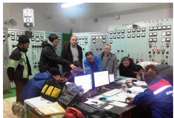
現地発電所オペレーター室で風車運転情報の収集方法を講習する様子
