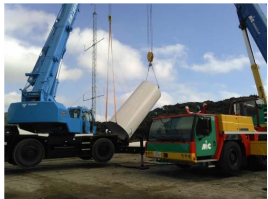
タワー建て起こし状況
