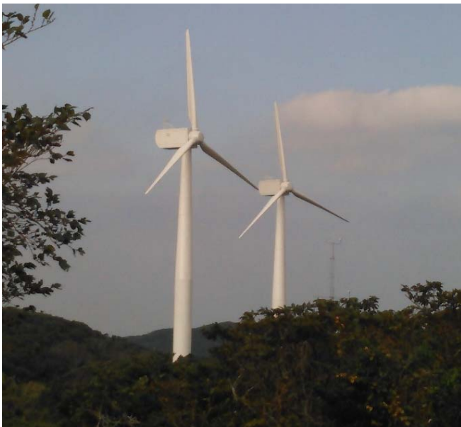
完成した風力発電機
