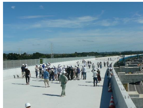
東海環状 大泉1高架橋
