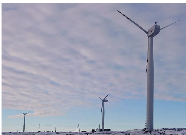
完成した3機の風力発電機
