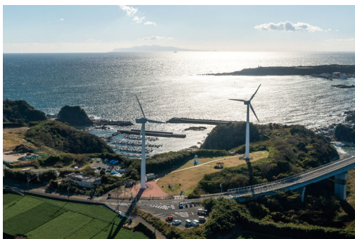
三浦宮川風力発電所
