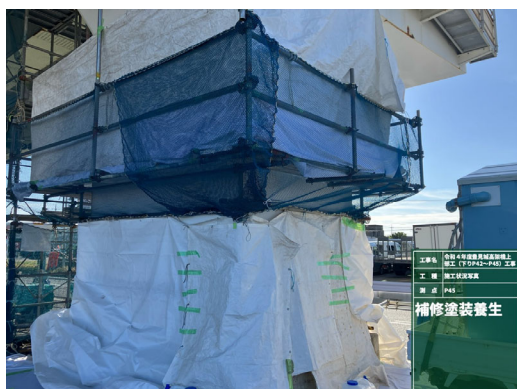
弱溶剤の塗料を用いた補修塗装
