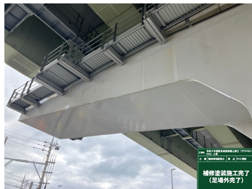
弱溶剤の塗料を用いた補修塗装
