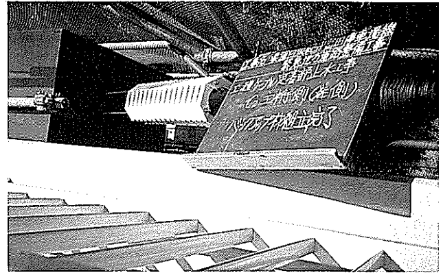
写真-10 ケーブルの制振装置の取付状況
