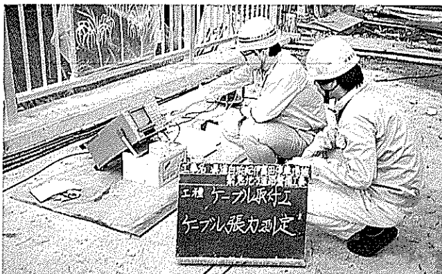
写真-9 ケーブル張力の測定
