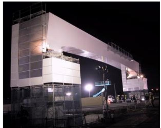
写真-4 添接作業完了後の BP8 鋼製橋脚全景
