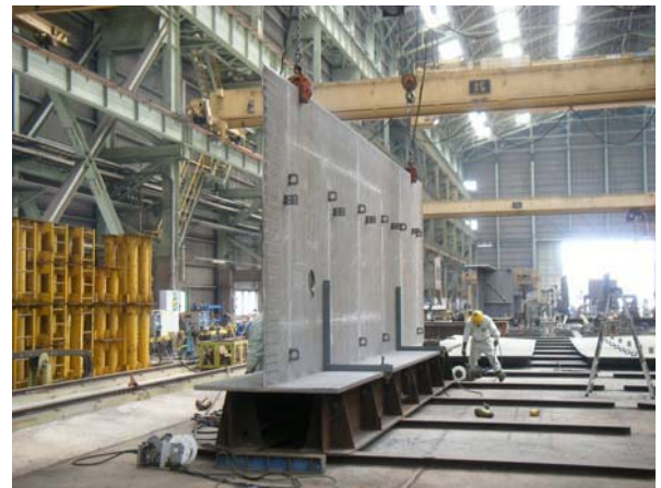
写真-4 主桁組立状況 (上フランジ+ウェブ)
