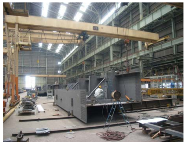
写真-5 主桁組立状況 (横リブ、下フランジ取付)
