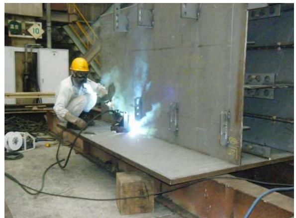
写真-2 鋼殻セル製作状況
