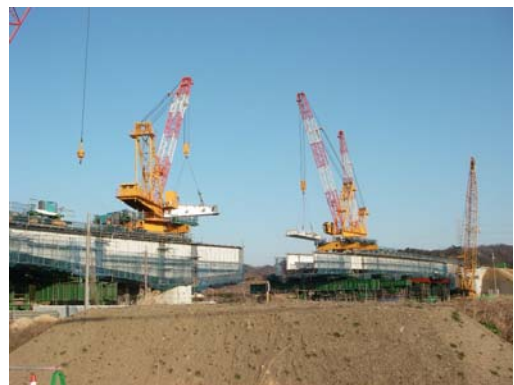
写真-7 トラベラクレーン
