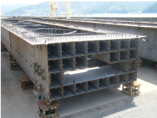
写真-3 鋼殻セル仮組立状況
