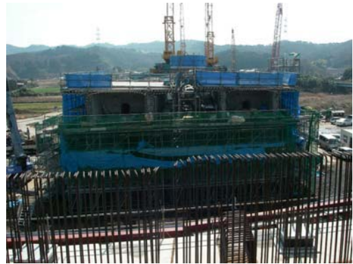
写真-6 PRC 桁（1次施工）
