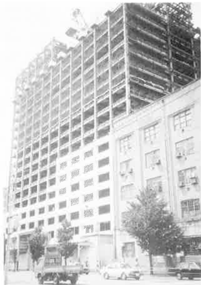
写真-2 鉄骨建方
