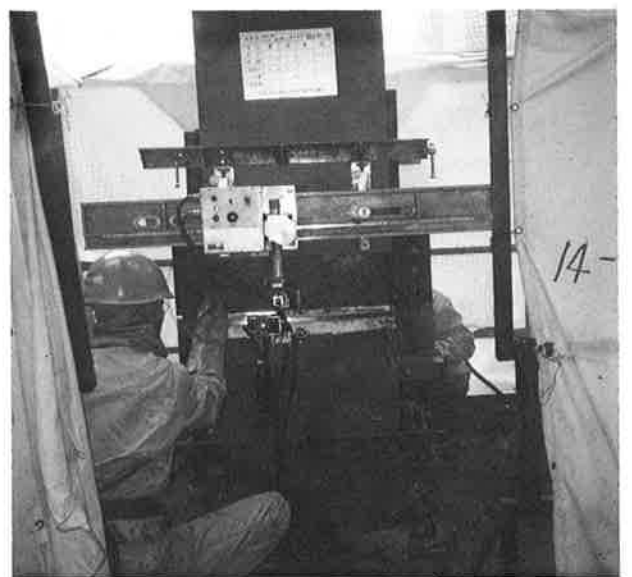
写-3 現場狭開先自動溶接
