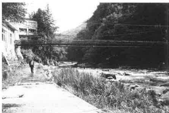
(a) 旧橋 (吊橋)
