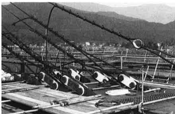
写真-1 P2タワーのケーブルアンカー
