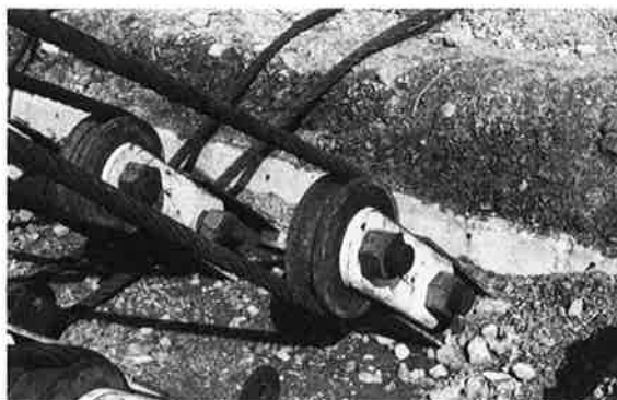
写真-2 P7タワーのケーブルアンカー
