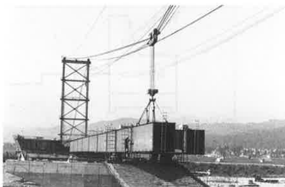
写真-3 P5からP6へ張出架設中
