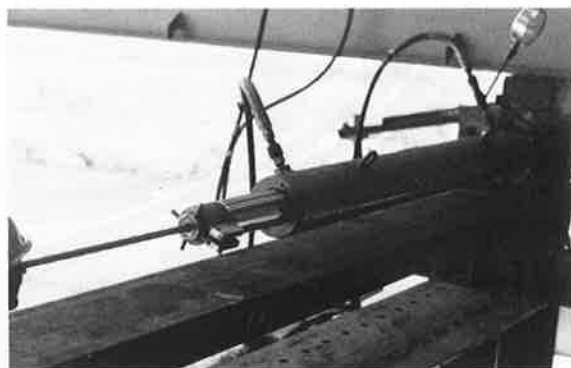
写真-4 P4センターホールジャッキ
