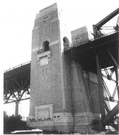
写真-7 橋門(パイロン)
