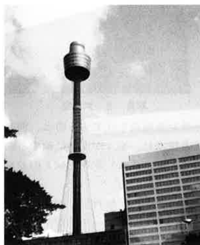
写真-4 センターポイントタワー
