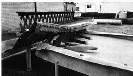
写真-9 落橋した桁の残骸
