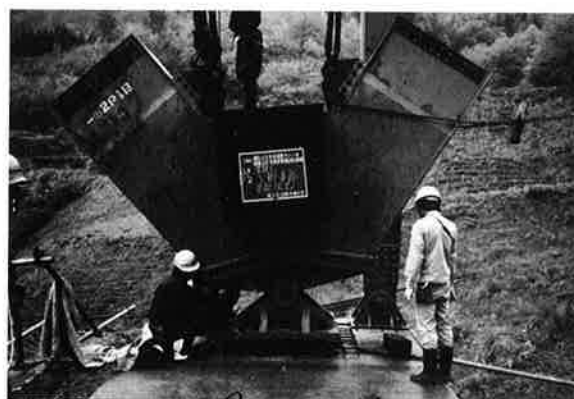
写真-4 V脚基部
