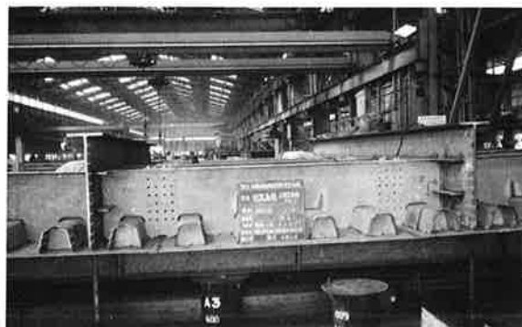
写真-6 組立作業
