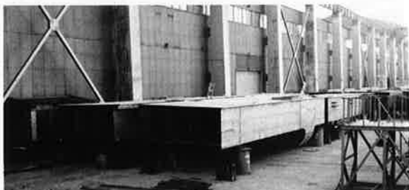
写真-1 溶接完了部材
