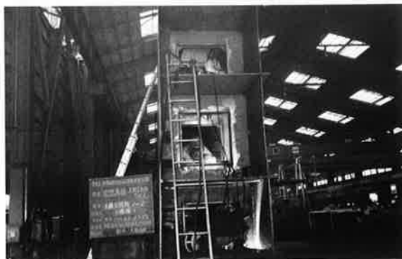
写真-2 溶接作業
