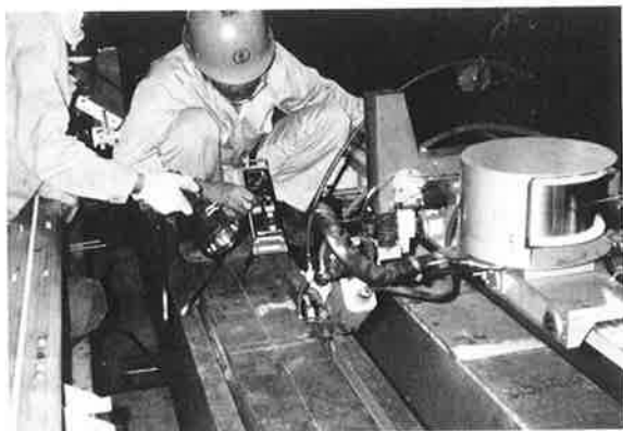
(b) 溶接線のティーチング
