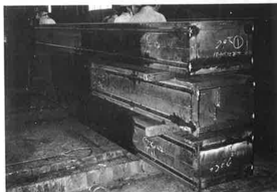
(e) 溶接が完了した箱型柱
