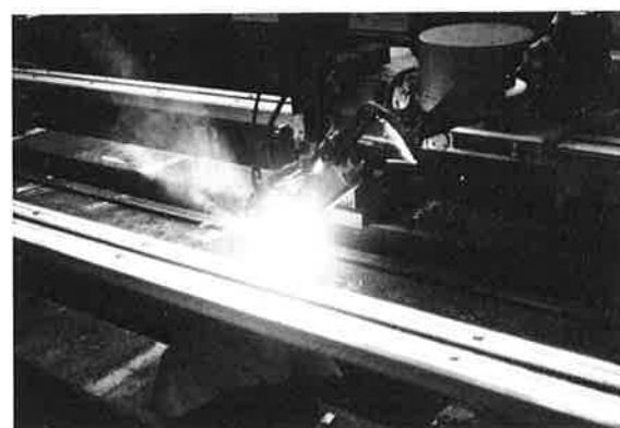
写真-3 溶接状況
