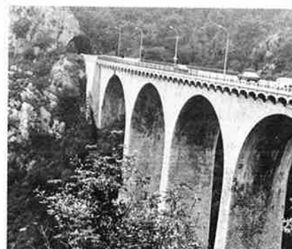
ニースの歩道拡巾橋
