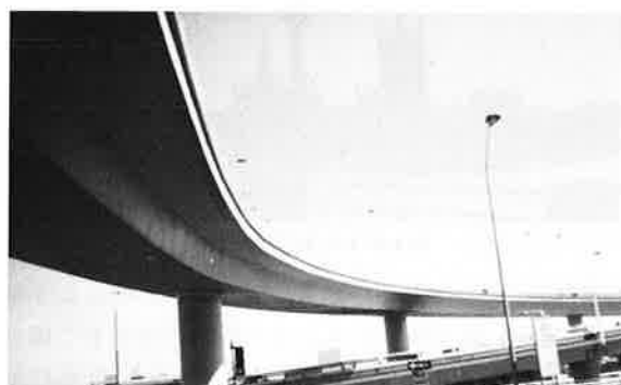
メルボルンの高速道路橋
