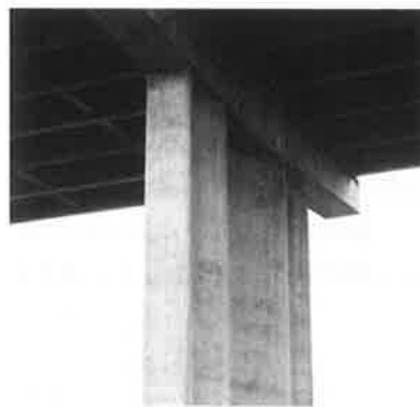
リルベルト橋の取付部の橋脚
