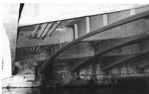
エイボン川の橋梁
