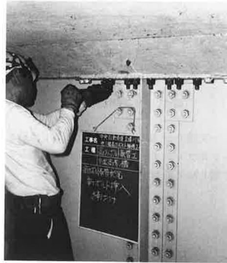
写真-2 特殊ボルトの挿入作業
