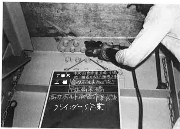
写真-1 抜取り後のケレン作業
