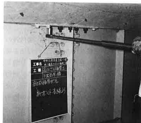
写真-4 本締め作業
