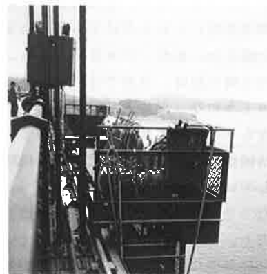
写真-20 外面作業車
