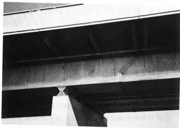
写真-3 ジョイント部
