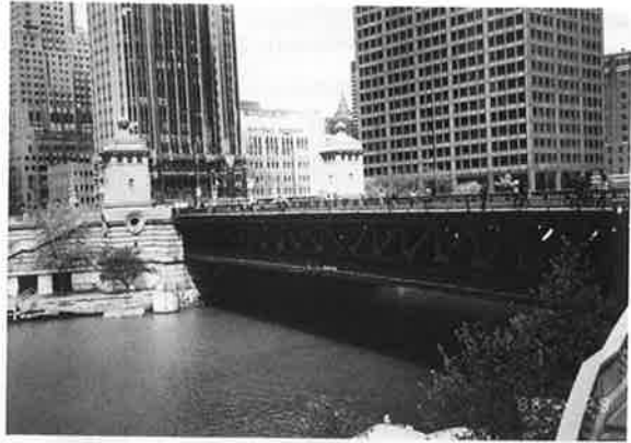
写真-11 シカゴ市内の橋梁
