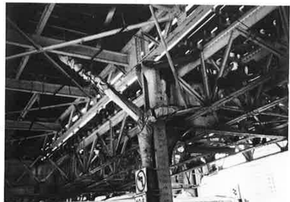
写真-14 地下鉄の高架
