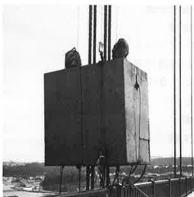
写真-19 ハンガーケーブルの作業車
