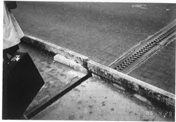
写真-12 伸縮継手部
