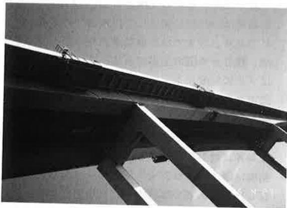
写真-2 サンマテオ橋中央付近
