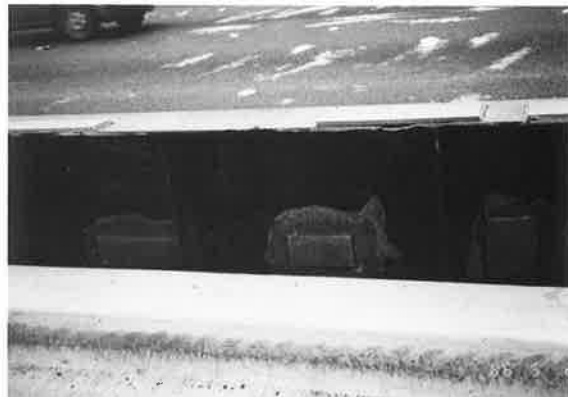
写真-21 側縦桁の補修のあと
