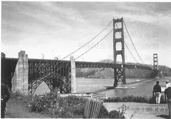
写真-17 ゴールデンゲート橋全景
