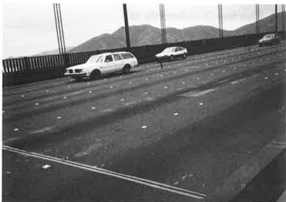
写真-18 中央分離帯のない道路部
