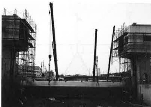
写真-4 扉体地組立
