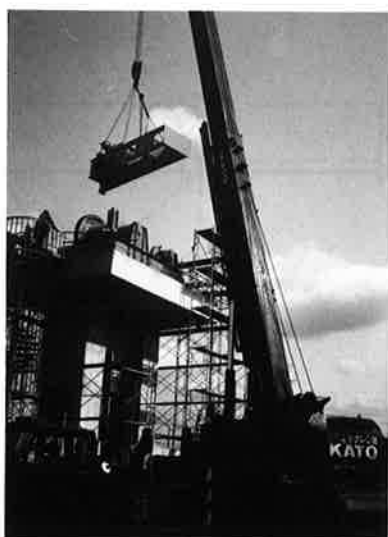
写真-5 開閉装置吊込み
