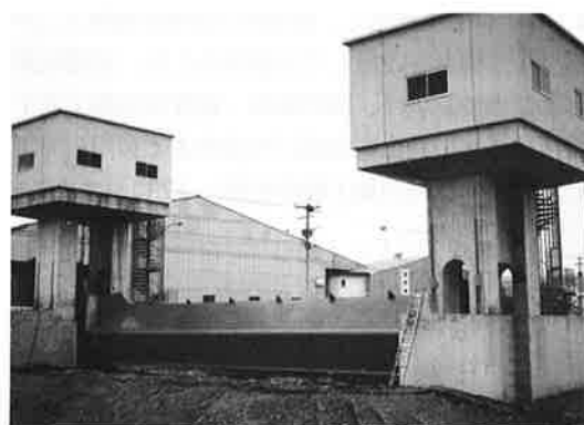
写真-7 完成写真（上流面）
