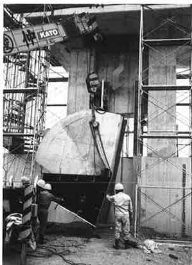
写真-3 扉体吊込み
