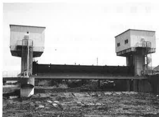
写真-6 完成写真（下流面）
