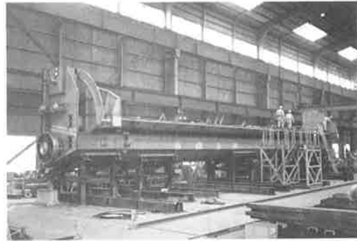
写真-1 工場仮組立
