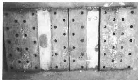
(a) 腹板シャーププレート部
