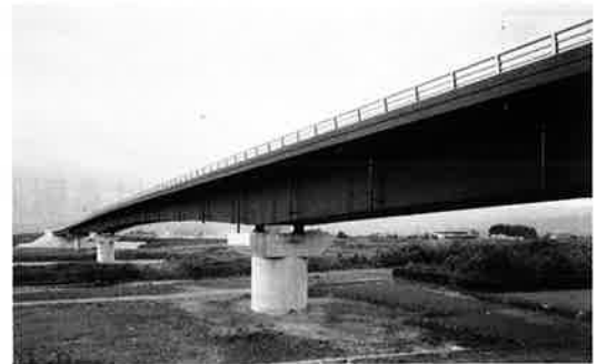
写真-1 日守大橋の外観
