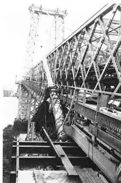
写真-3 メインケーブルの補修
