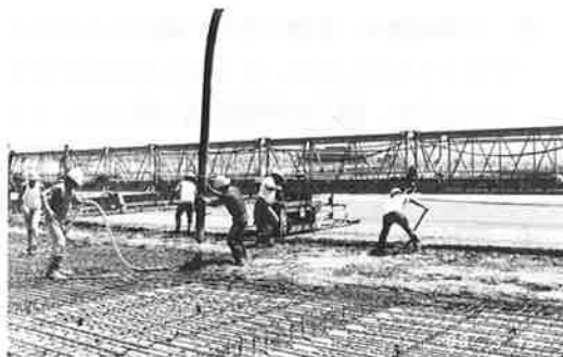
写真-10 コンクリート打設状況
