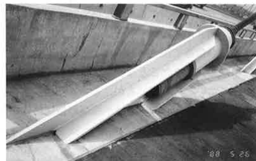
写真-53 ケーブル定着部(桁側)構造
