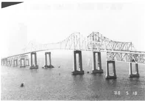
写真-22 旧橋の撤去
