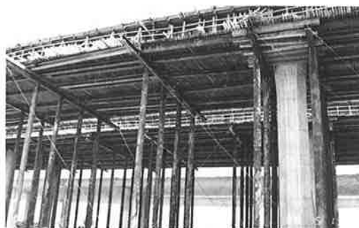
写真-9 橋梁架設現場
