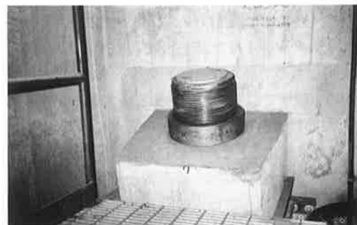
写真-52 ケーブル定着部(塔側)構造
