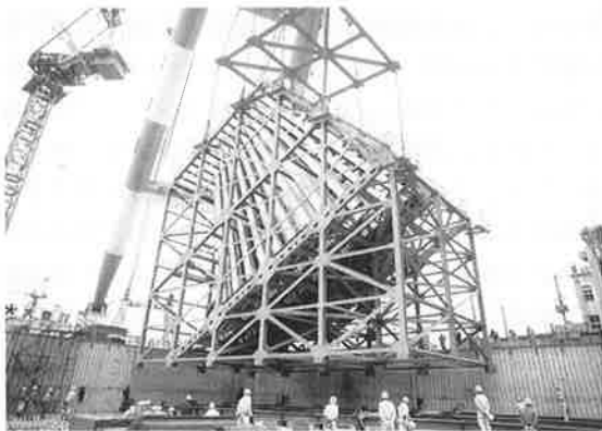
写真-5 吊り降ろし
