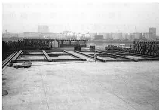
写真-2 地組立架台
