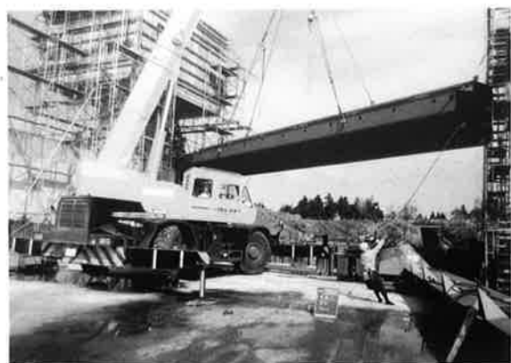
写真-1 扉体吊込み
