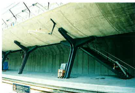
写真-45 天井を支える柱
