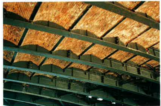
写真-11 シュリー橋の床版
