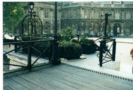
写真-21 ポン・デザールの取付部
