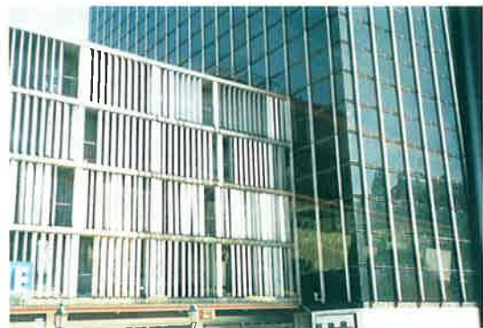
写真-81 取り壊されるビル
