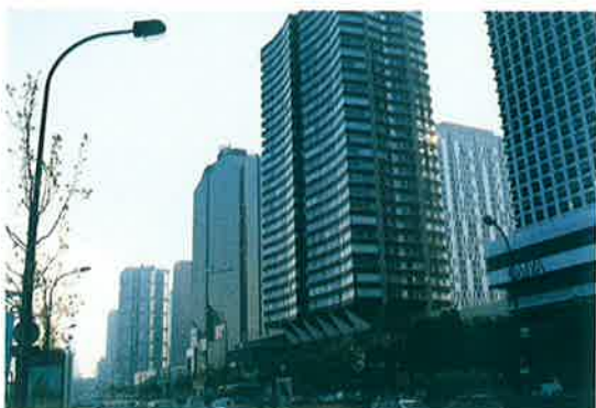
写真-7 グルネル橋付近
