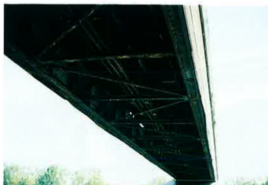
写真-23 ソルフェリーノ橋の下面
