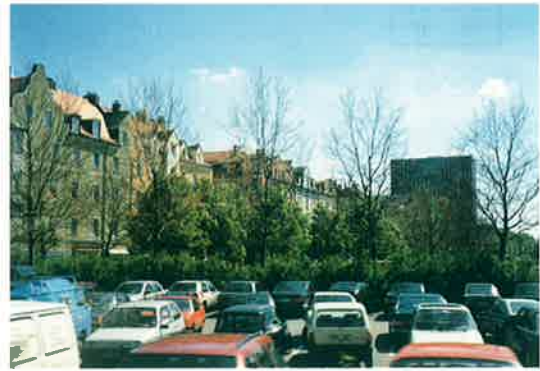
写真-80 シュバーベン地区 (黒いビルが取り壊される)
