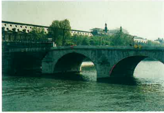
写真-17 修復作業中のポン・ロワイヤル
