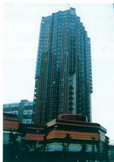
写真-8 グルネル橋付近
