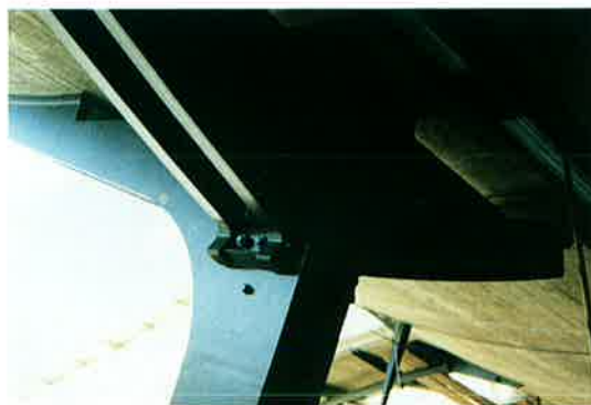
写真-46 柱の細部
