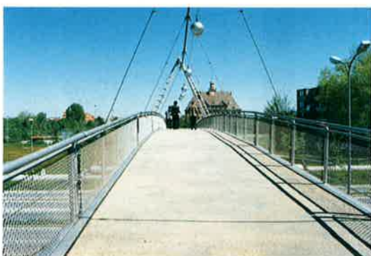
写真-77 歩道橋の橋面
