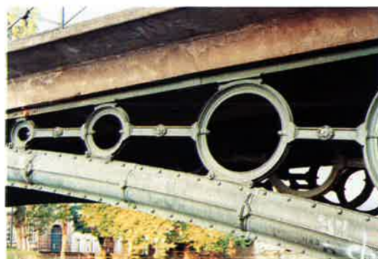
写真-35 マルチン・ルター橋
