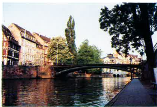
写真-34 マルチン・ルター橋
