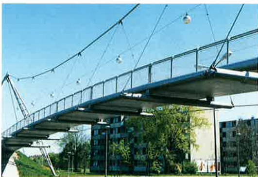
写真-78 歩道橋の下面
