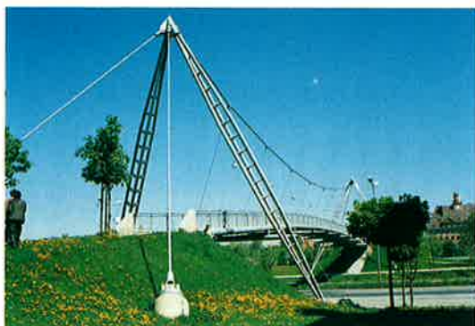
写真-76 ベルリーナ Str. 地区の歩道橋
