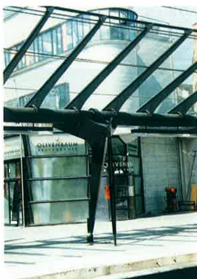
写真-43 ホームの上屋と柱
