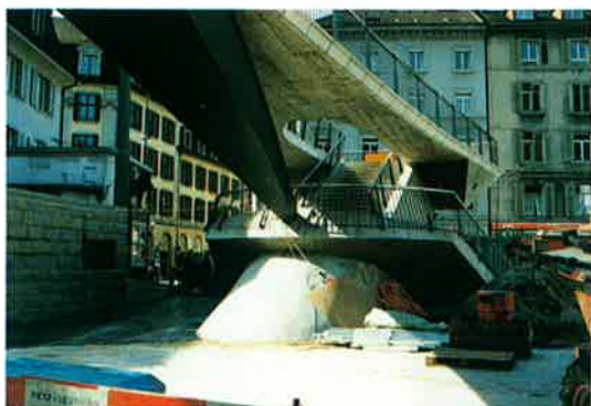
写真-50 歩道橋の取付部
