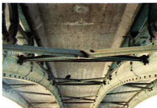
写真-36 マルチン・ルター橋の床版
