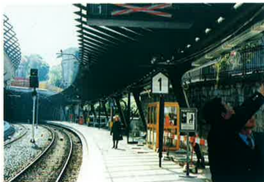
写真-44 ホームの上屋
