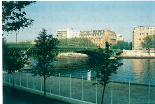
写真-30 ミラボウ橋
