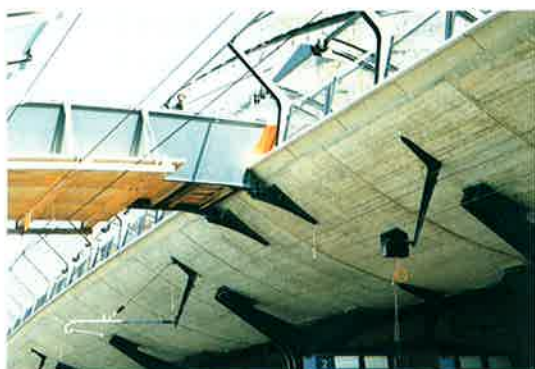
写真-48 歩道橋とホームの天井
