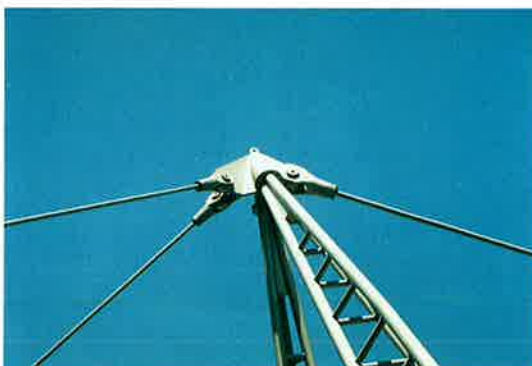
写真-79 歩道橋の塔柱の先端
