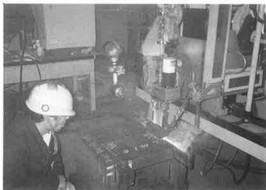
写真-3 溶接風景 (アークモニター)
