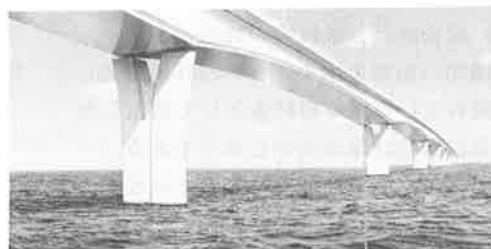
写真-10 東京湾横断道路橋梁部のデザイン
