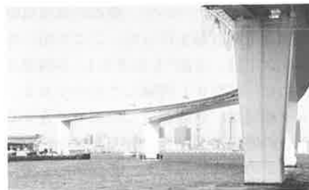
写真-9 完成近い有明西運河橋
