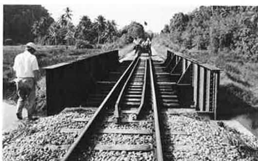
写真-15 スパン15m リベット構造（アメリカ製）
