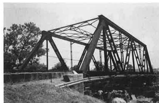
写真-11 スパン30m リベット構造 (ドイツ製)
