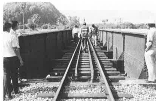
写真-10 スパン20m リベット構造 (フランス製)
