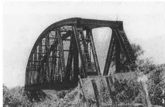
写真-8 スパン80m リベット構造 (フランス製)
