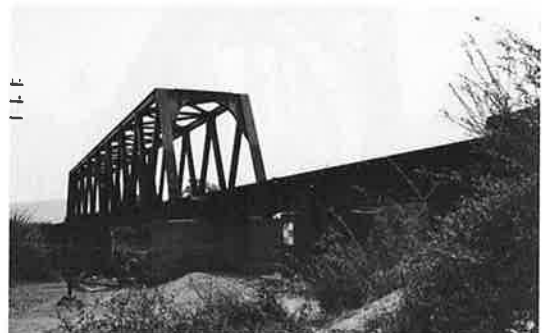
写真-17 スパン53m 溶接構造（日本製）
