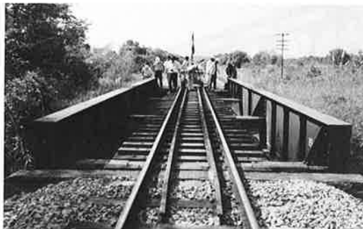
写真-13 スパン15m リベット構造（ドイツ製）
