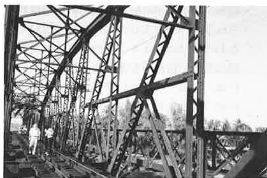
写真-22 斜材垂直材の補強で座屈長を短かくした例
