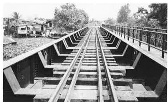
写真-19 スパン15m 溶接構造（台湾製）
