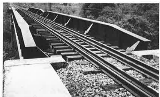
写真-18 スパン20m 溶接構造（日本製）
