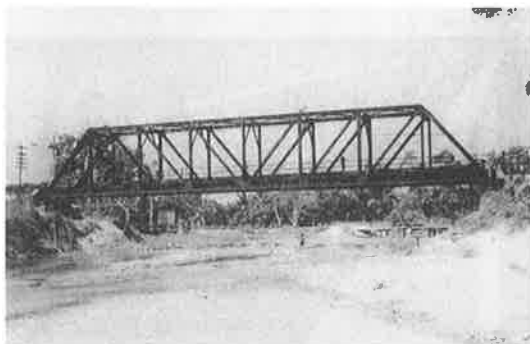
写真-6 スパン45m リベット構造 (イギリス製)
