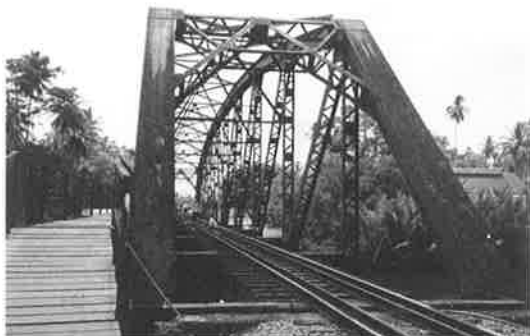
写真-5 スパン80m リベット構造 (イギリス製)
