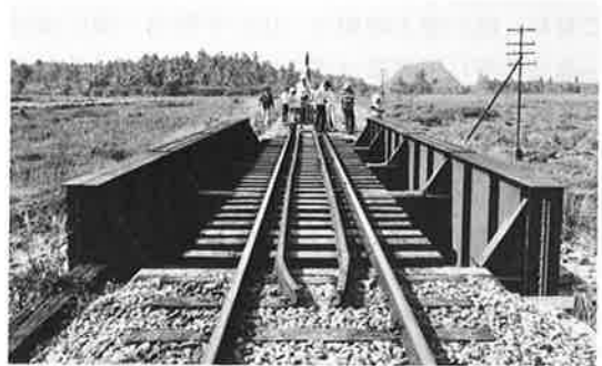
写真-16 スパン15m リベット構造（タイ国製）
