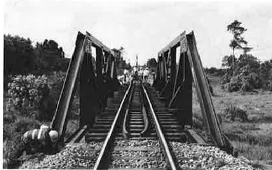
写真-12 スパン20m リベット構造（ドイツ製）
