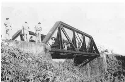
写真-7 スパン25m リベット構造 (イギリス製)
