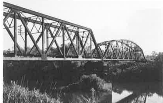
写真-9 スパン65+70m リベット構造 (フランス製)
