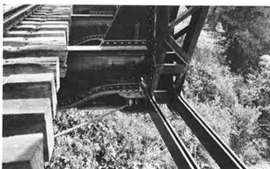
写真-14 スパン40m ピン結合トラス格点部（アメリカ製）
