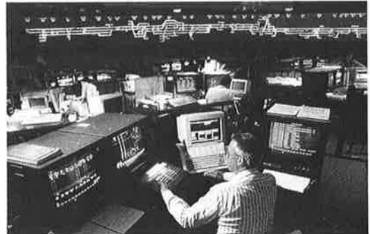
写真-2 コンピューター室
