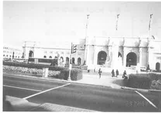
写真-4 ワシントンユニオン駅正面出入口
