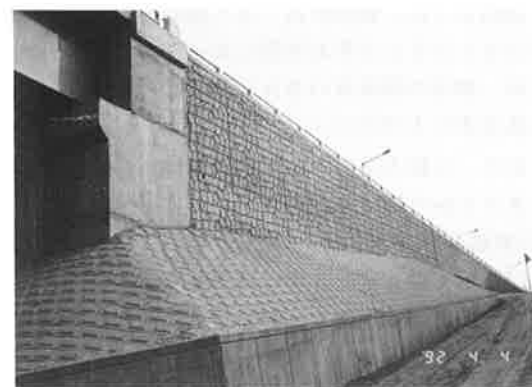
写真-11 化粧型枠の使用(ソウル)
