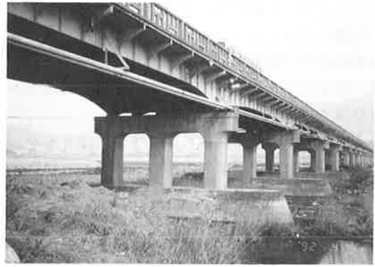
写真-7 亀浦橋(釜山)
