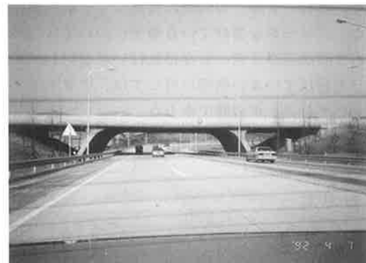
写真-10 高速道路のオーバブリッジ(ソウル)
