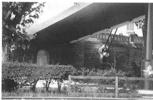
写真-12 ホルバイン橋のケーブルアンカー部
