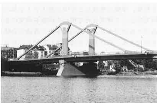
写真-15 フロッサー橋
