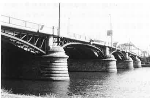
写真-14 オーバーメイン橋
