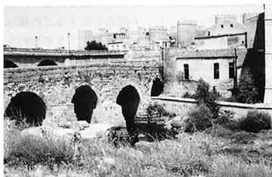
写真-9 アビラの石造アーチ橋
