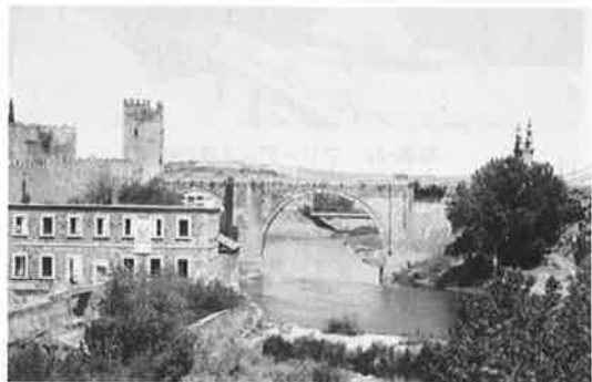
写真-7 アルカンタラ橋
