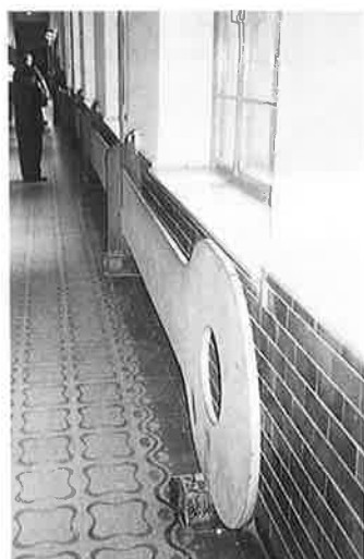
写真-7 くさり橋アイバー (ブダペスト工科大学内)
