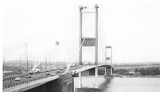
写真-37 セバーン橋
