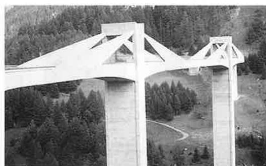
写真-25 ガンター橋
