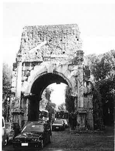
写真-30 ローマに残る水道橋
