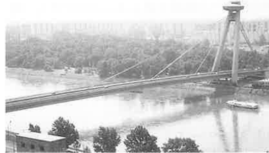
写真-11 ブラチスラバ橋
