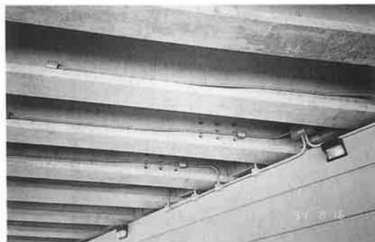
写真-11 計測装置とアウトケーブル用穴
