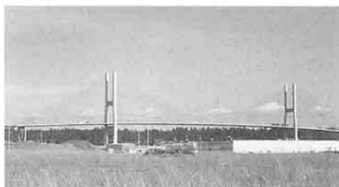
写真-14 アレックスフレザー橋全景
