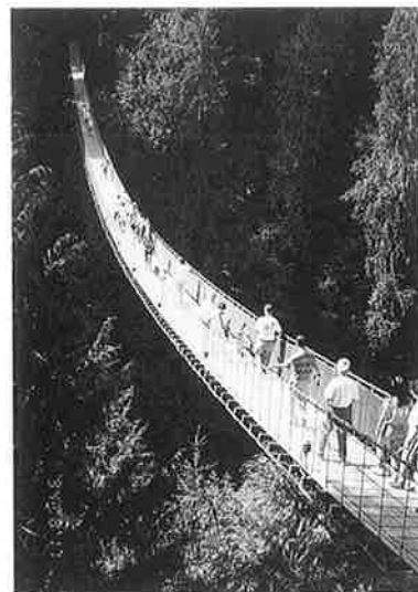
写真-19 カピラノ溪谷の吊橋
