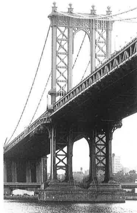
写真-2 マンハッタン橋
