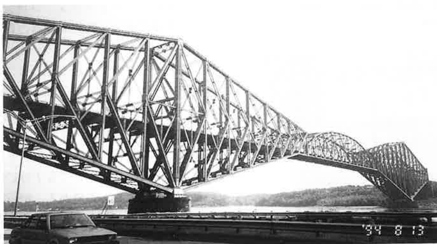
写真-9 ケベック橋の全景
