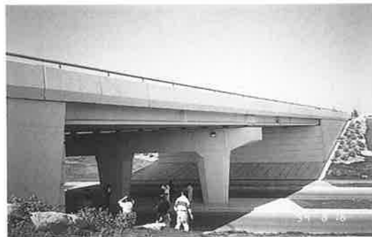
写真-10 新素材を用いたPC橋
