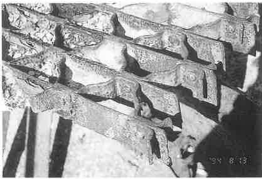
写真-7 取り除かれたグレーチング
