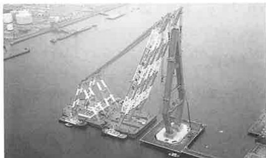
写真-7 塔上部架設
