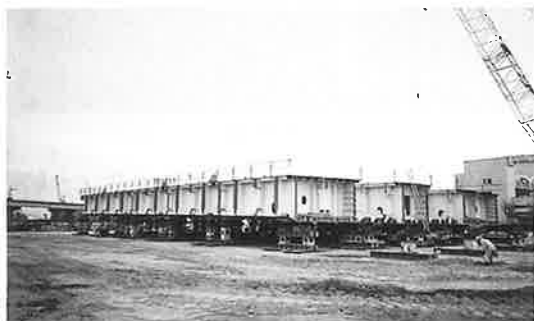
写真-3 主桁の地組立
