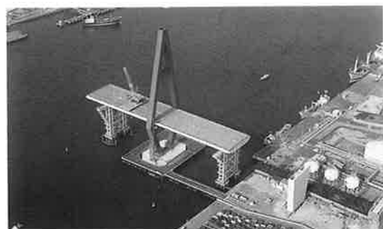
写真-8 大ブロック架設完了
