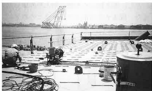
写真-4 主桁のヤード溶接
