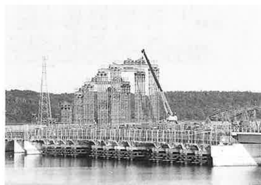
写真-2 上弦材ベント設備
