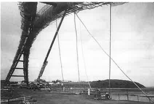
写真-4 ケーブルの架設
