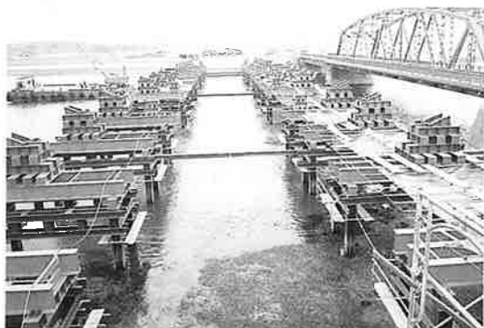
写真-1 下弦材ベント設備
