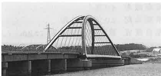
写真-5 完成写真
