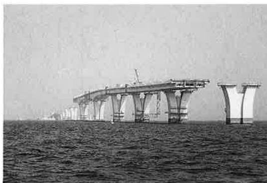
写真-8 B8 架設完了
