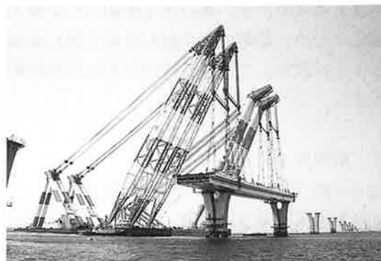
写真-5 B10架設状況
