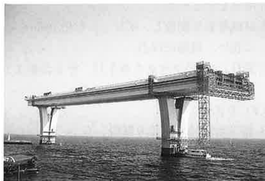
写真-6 B10架設完了
