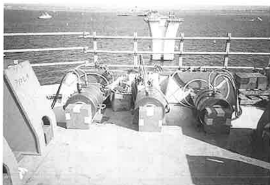
写真-9 ジャッキ据付状況
